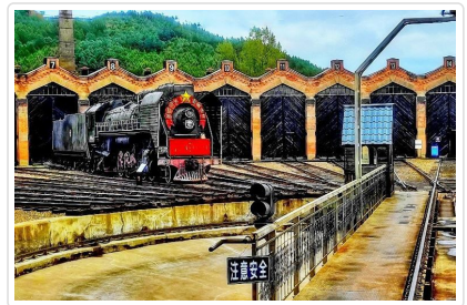
橫道河子鎮 中東鐵路機車庫
