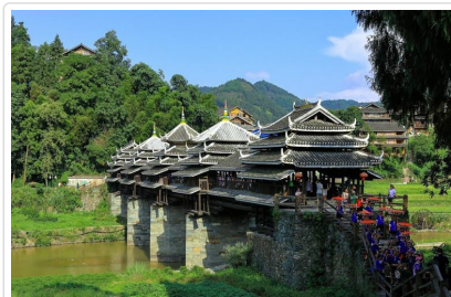
程陽八寨 風雨橋
