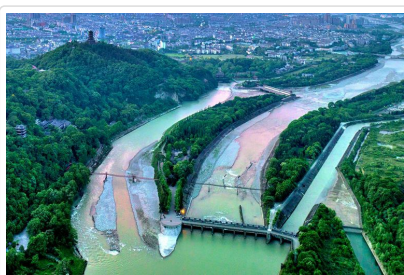
都江堰 水利工程
