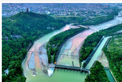
都江堰 水利工程
