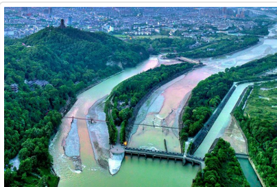
都江堰 水利工程
